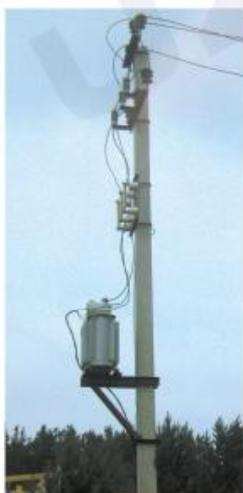
Столбовые комплектные трансформаторные подстанции КТП ВС (сельского типа) применяется для электроснабжения коттеджей, промышленных, сельскохозяйственных коммунальных объектов в кольцевых или радиальных схемах распределительных сетей.
